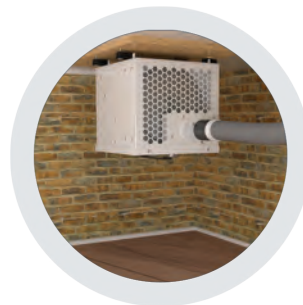
• in de kelder
